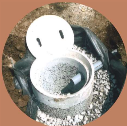
浸透ます（施工中）
